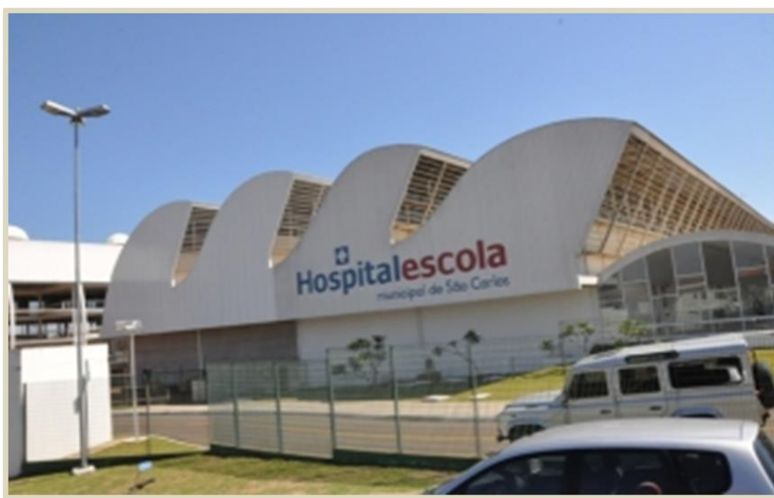
Figura 1: Escola hospital de São Carlos – SP. Fonte: TACONELLI, 2013.
